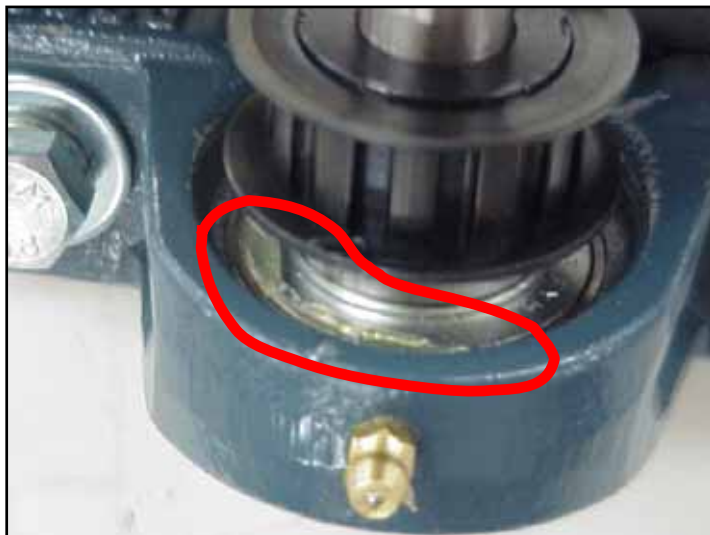
グリスがファンユニットから滲み出すまで注入
